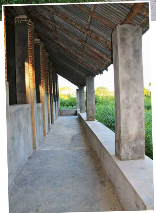
Arbeiten am Schulgebäude (oben) und die renovierte Terasse (unten)
