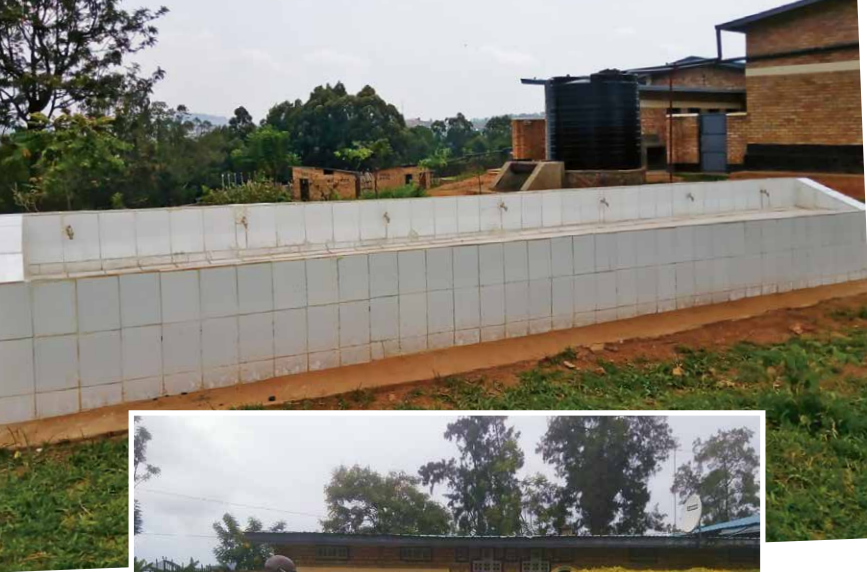
Bau des Handwaschbeckens als Teil der Hygiene-Station vor der Kirche
