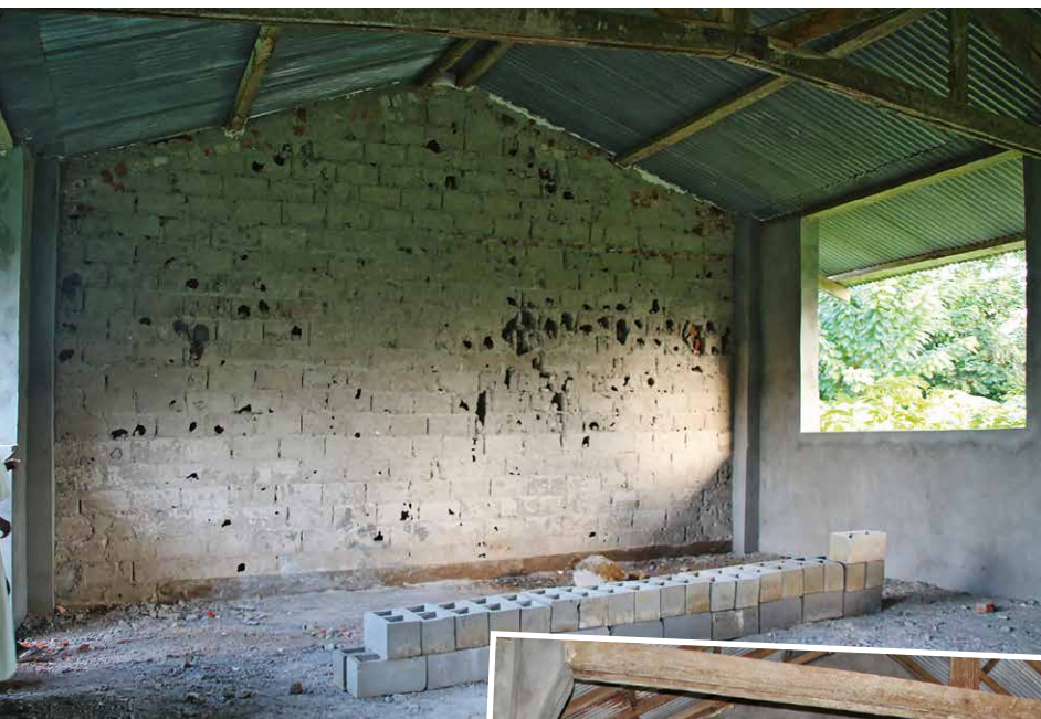
Klassenraum vor der Renovierung (oben) und danach (unten) © Fotos: Privat
