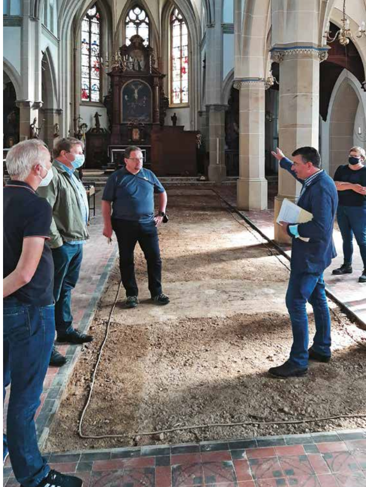
Schadensbegutachtung St. Martin Flerzheim
