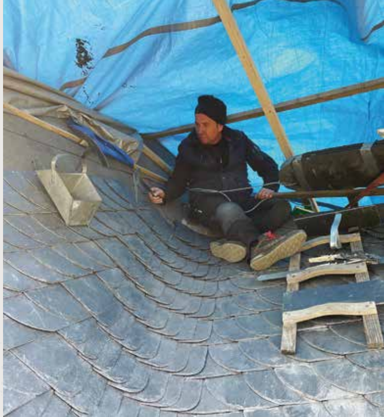
Dachdeckermeister Achim Weber bei Dacharbeiten Foto: Privat
